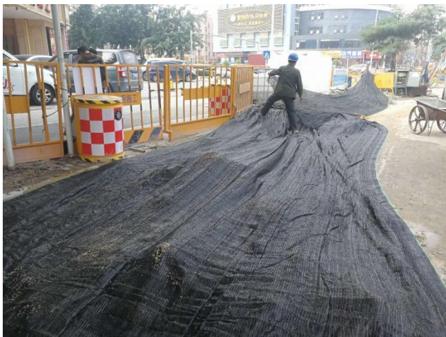
施工期渣土覆盖防尘照片
